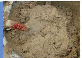
Für Kalkzementmörtel wird noch Kalk hinzugefügt. Den Mörtel mischt man von Hand an oder mit einem Rührwerk/Mörtelmischer. Für flüssigen Mörtel nimmt der Maurer mehr Wasser.
