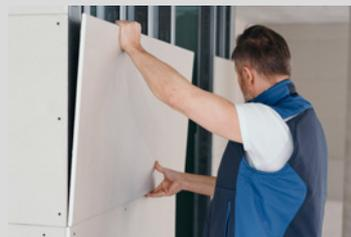
**1.** Der Stuckateur montiert Decken und Wände aus Gipskartonplatten.
